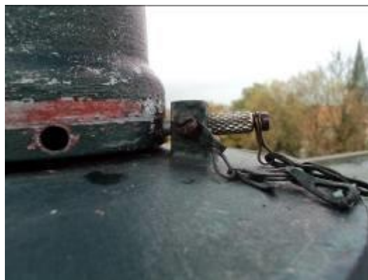
Bild 1. Arretierung des drehbaren Fallentopfs mit einem Bolzen
